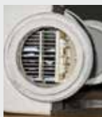
Filtere de piscine
