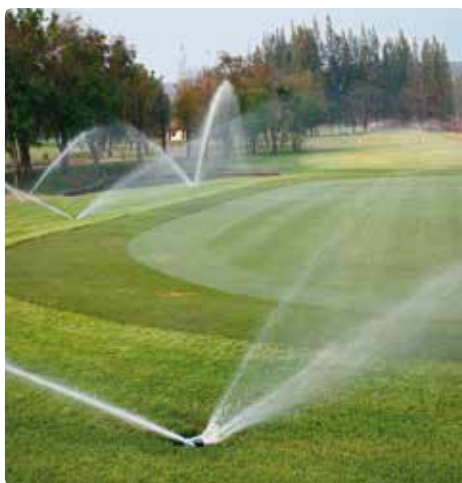
Installation de sprinklers sur un terrain de golf
