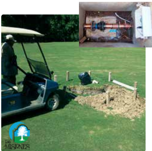
Instalación subterránea en el campo de golf Las Misiones
